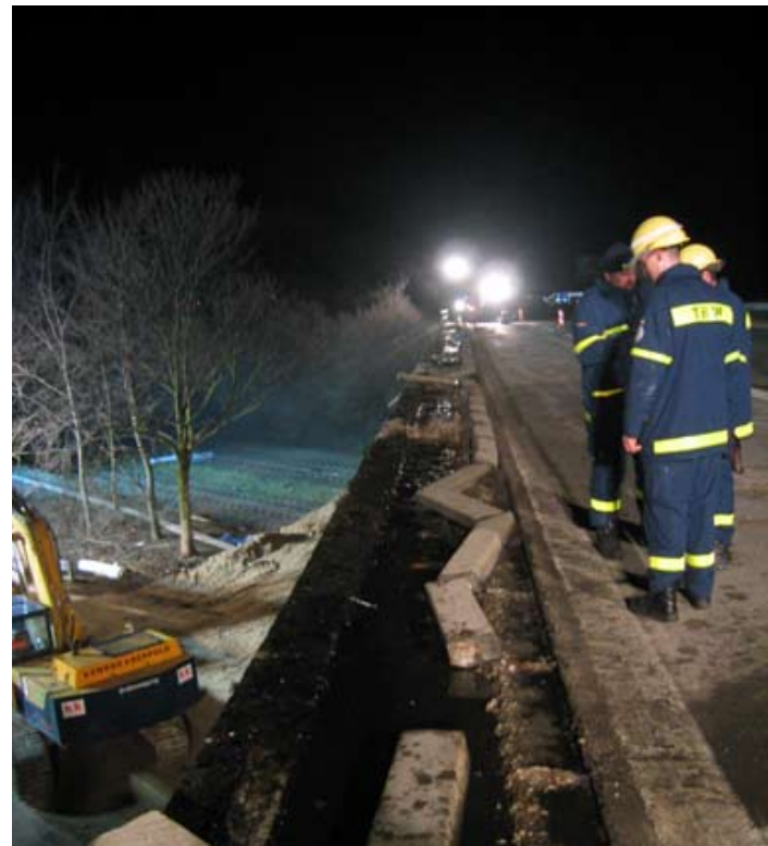
Unaufschiebbare Abbrucharbeiten an einer Autobahnbrücke (2004)
