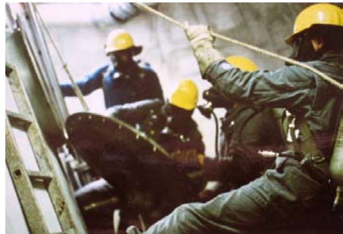
Instandsetzung eines Münchner Klärwerkes unter Atemschutz im Jahr 1988
