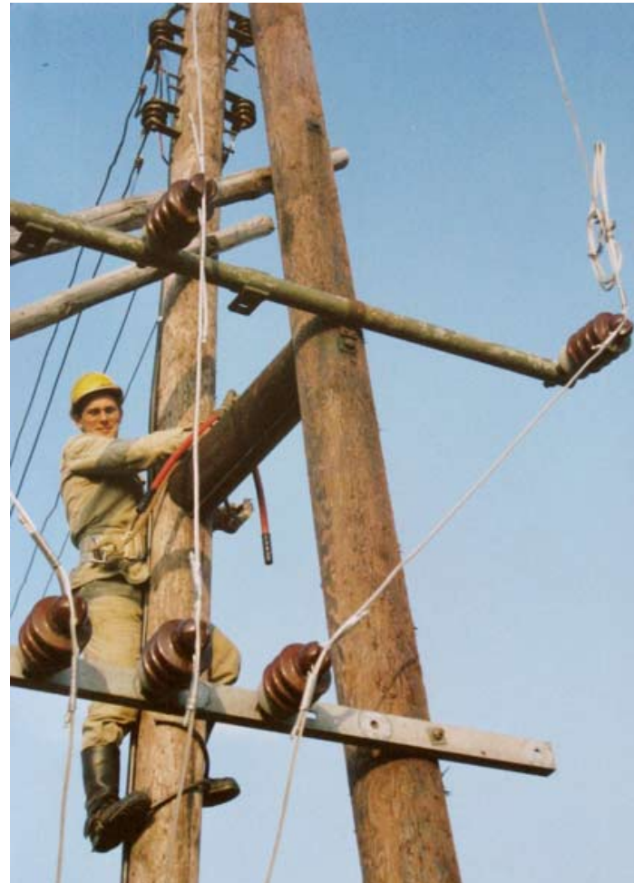
Ein Helfer des THW Markt Schwaben bei der Instandsetzung einer Mittelspannungsleitung
