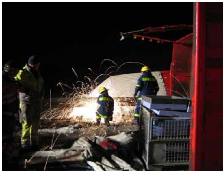
Helfer aus Markt Schwaben entfernen eine Leitplanke.
