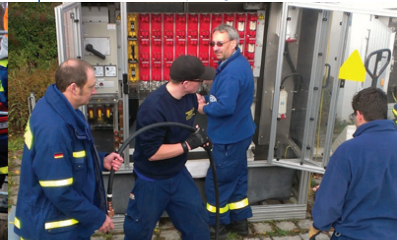
Aufbau einer Stromeinspeisung.
